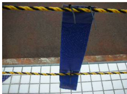
④シートのめくり上がりを防ぐには裏側の白いタグに取付けバンドを通す。 その際、 風に揺れるよう ロープに緩めに留める。
